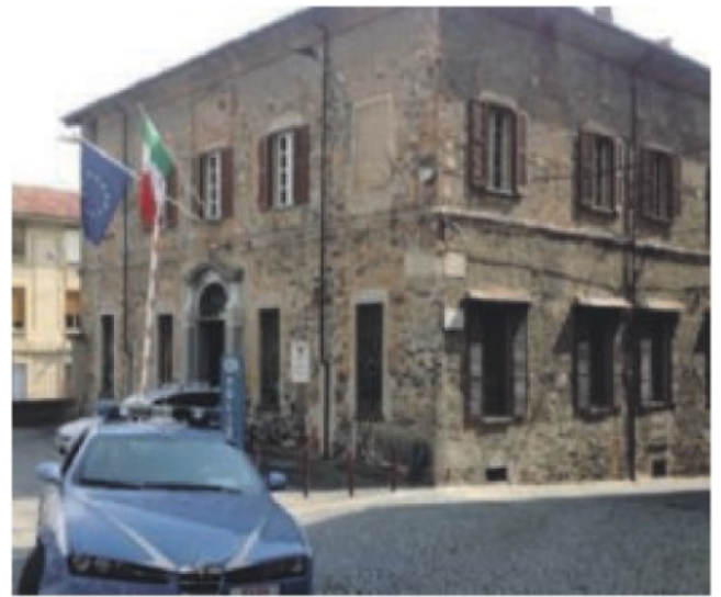
Servono rinforzi per il commissariato
